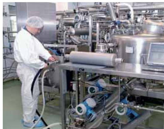
Taratura di misuratori di portata in loco con impianto di taratura mobile
