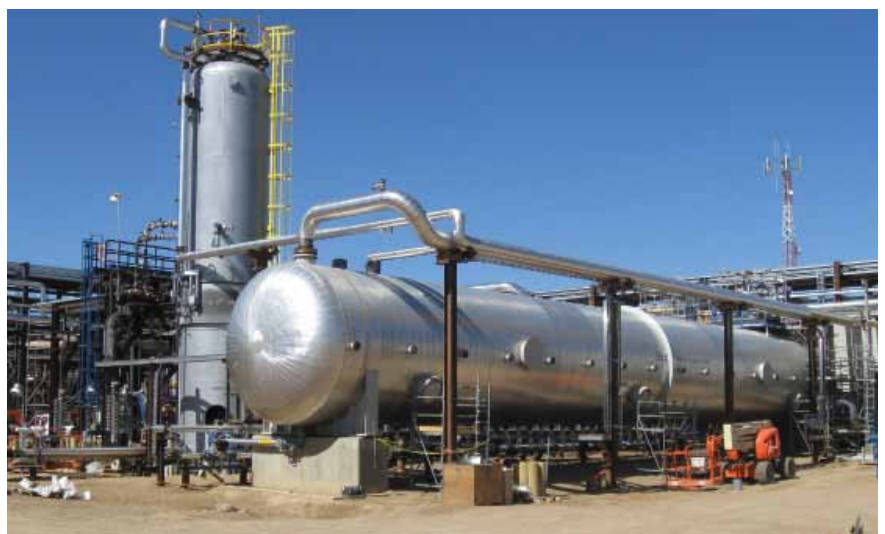
Serbatoio di separazione acqua/olio/sabbia della Devon Energy Corporation
