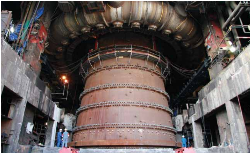
Altoforno HF1 della ArcelorMittal
