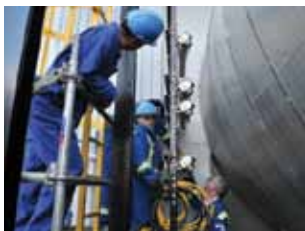
Installazione FOUNDATION Fieldbus, SC Canada
