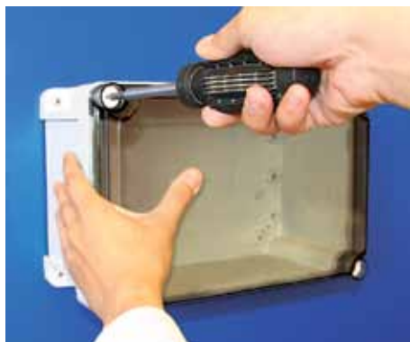
Umocować obudowę na ścianie
