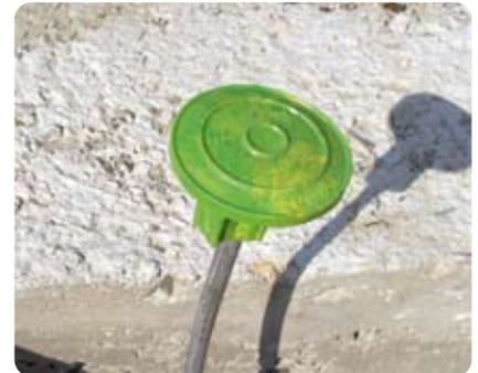
Copertura di protezione su linguetta di connessione
