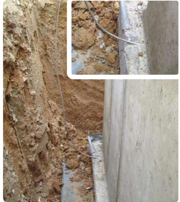
Linguetta di connessione in INOX (AISI 316) resistente alla corrosione
