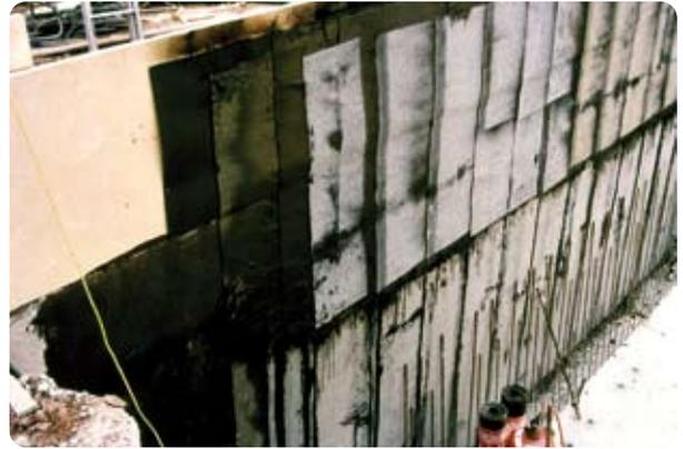
Membrane bituminose di isolamento
