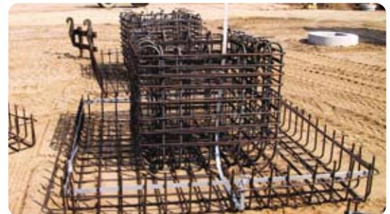
Dispersore in una fondazione a plinti con linguette di connessione
