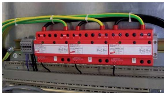
Figura 9.16.4 Installazione dello scaricatore coordinato DEHNbloc Maxi nel sistema 400/690 V TN-C
