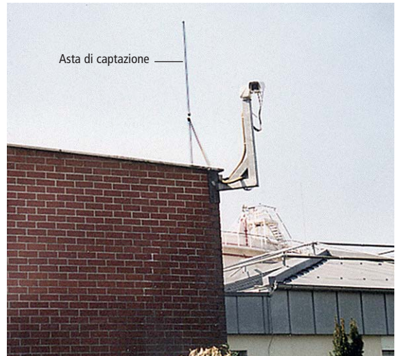
Figura 9.7.2 Telecamera nell'area protetta di un'asta di captazione
