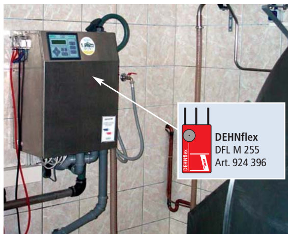
Figura 9.6.3 Impianto di aerazione e lavaggio
