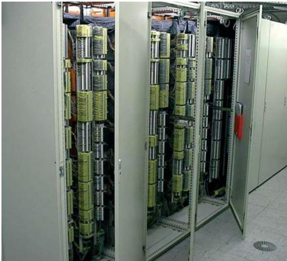
Figura 9.4.7 Dispositivo di protezione da sovratensioni DCO ME 24 nel quadro di comando per la protezione del completo sistema CMR
