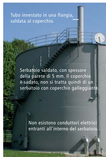
Figura 9.3.8 Serbatoio in acciaio saldato (Fonte: Eisenbau Heilbronn GmbH)
