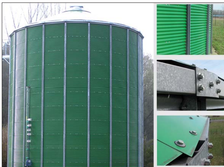
Figura 9.3.6 Fermentatore in lastre metalliche avvitate
