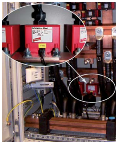
Figura 8.1.6.5 DEHNbloc Maxi S: scaricatore di corrente da fulmine coordinato con prefusibile integrato
