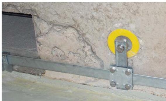
Figura 7.7.1.1 Collettore equipotenziale ad anello e punto fisso di messa a terra per la connessione di corpi metallici
