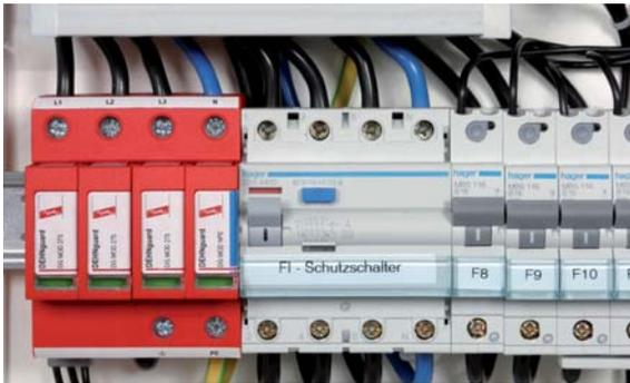
Figura 7.7.2.3 Limitatore di sovratensione multipolare DEHNGuard M TT
