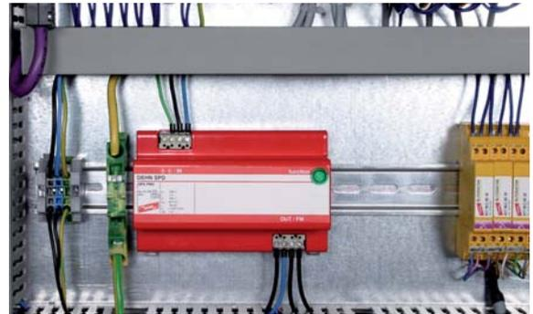
Figura 7.7.3.1 Protezione per utilizzatori elettronici industriali (p.es. PLC) con BLITZDUCTOR CT e SPS-Protector
