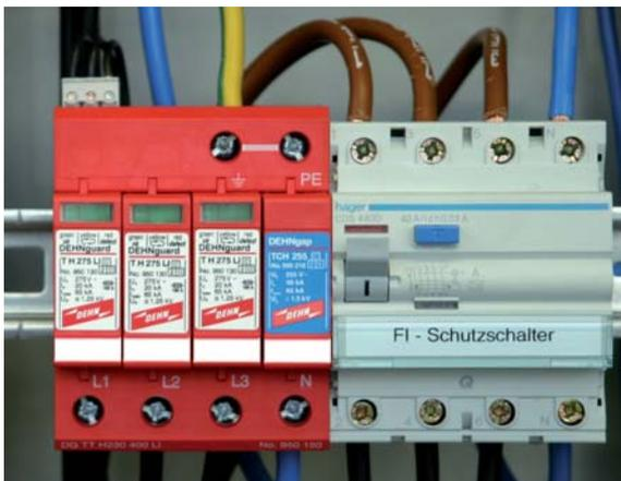
Figura 7.8.1.2 DEHNGuard TT H LI - Limitatore di sovratensione multipolare
