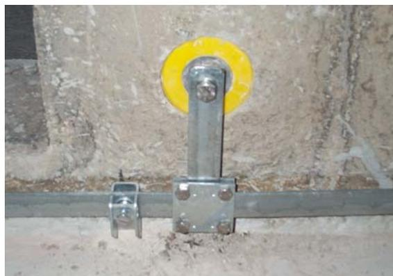
Figura 7.4.3 Collegamento del collettore ad anello al sistema equipotenziale attraverso punto fisso di messa a terra
