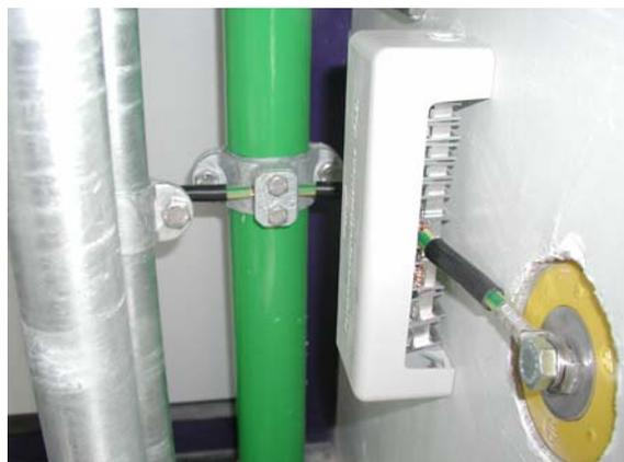
Figura 7.5.1.1 Connessione EB al punto fisso di terra
