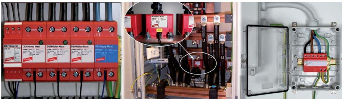
Figura 7.5.2.7 Scaricatori di corrente da fulmine nel passaggio LPZ 0<sub>A</sub> – 1
