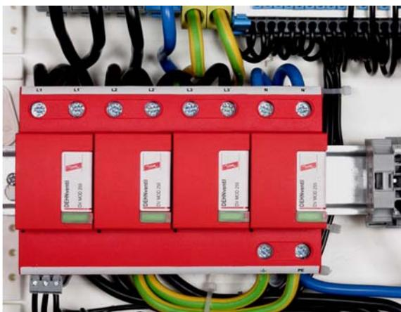
Figura 7.8.1.3 DEHNventil M TNS – scaricatore combinato modulare
