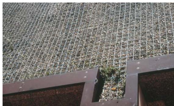
Figura 7.3.7a Rete elettrosaldata zincata per la schermatura di un edificio
