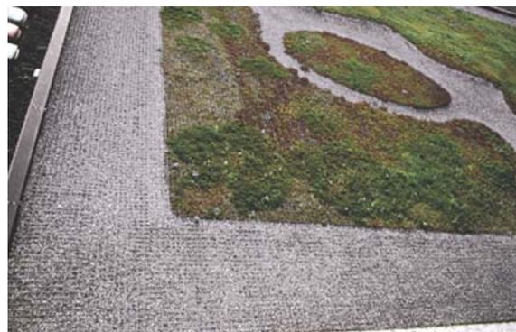
Figura 7.3.7b Utilizzo della rete elettrosaldata zincata per la schermatura, ad esempio in caso di tetto verde
