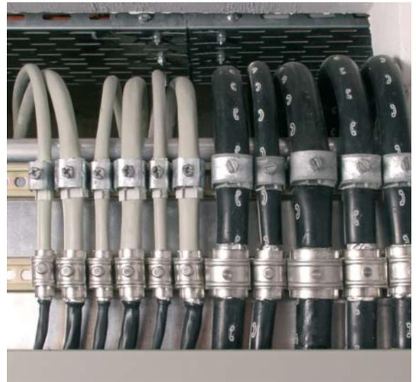
Figura 6.3.3 Sistema di connessione per schermi tipo SAK a tenuta di corrente da fulmine
