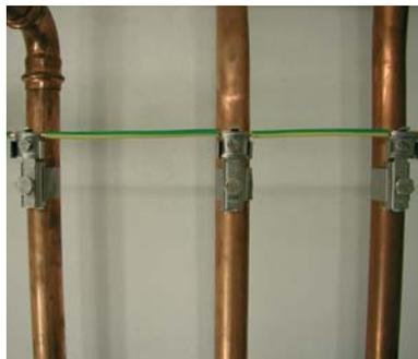
Figura 6.1.6 Collegamento equipotenziale passante
