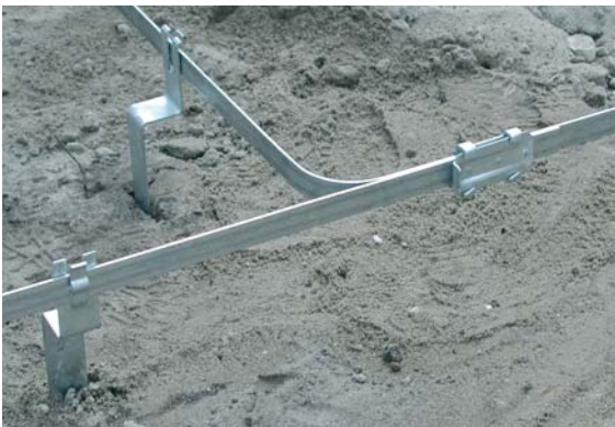
Figura 5.5.2.3 Dispersore di fondazione
