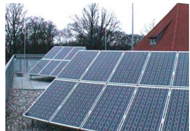
Figura 5.1.8.6 Sistema di captazione isolato per l'impianto fotovoltaico
