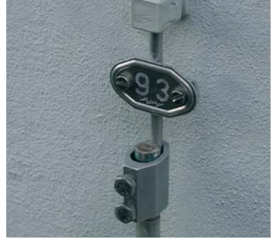
Figura 5.2.2.3.1 Punto di misura con numero di identificazione
