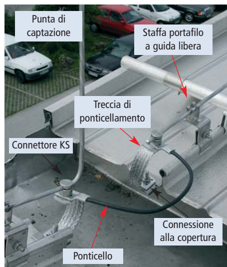
Figura 5.1.4.4b Staffa portafilo per tetto in metallo - Ribordatura tonda
