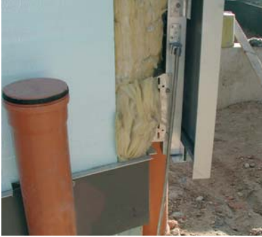
Figura 5.2.2.2.3 Collegamento a terra della facciata metallica
