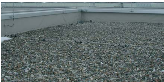
Figura 5.1.3.2 Dispositivo di captazione su un tetto piano
