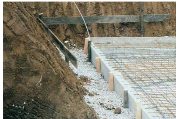
Figura 5.5.2.4 Utilizzo del dispersore di fondazione
