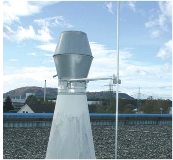
Figura 5.1.8.3 Asta di captazione con distanziatore
