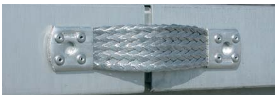
Figura 5.1.3.4 Ponticellamento dell'attico
