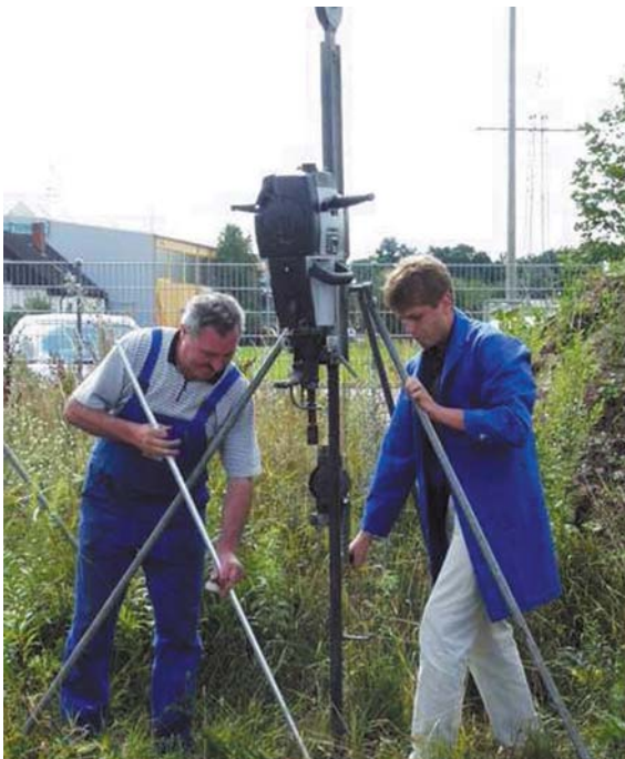
Figura 5.5.4.2 Installazione del dispersore di profondità con supporto e martello vibratore
