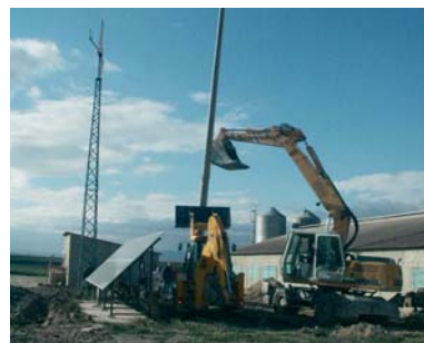
Figura 5.1.8.9 Posizionamento di un palo componibile in acciaio per la protezione contro i fulmini
