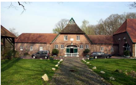
Figura 5.1.5.4 Fattoria storica con impianto di protezione esterno (Fonte foto: Hans Thormählen GmbH & Co.KG.)
