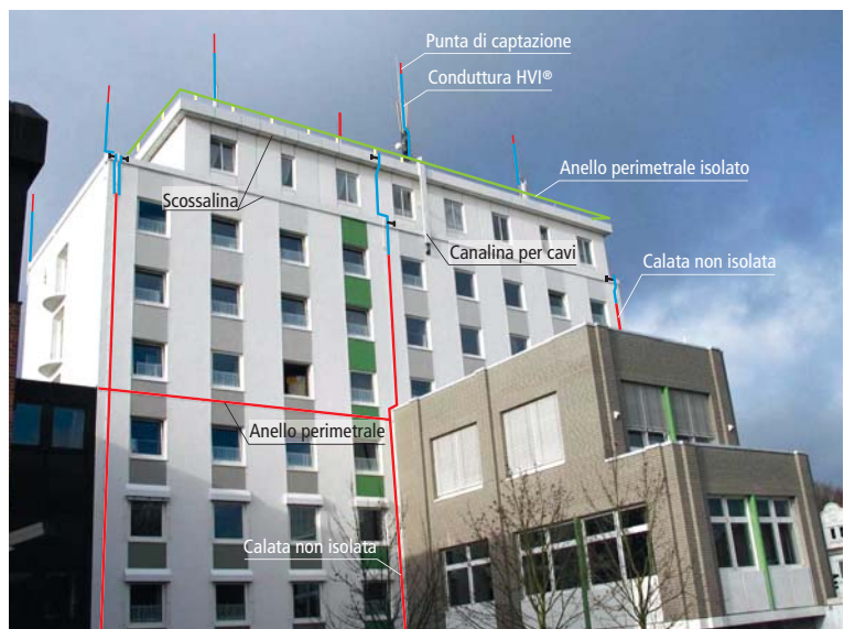
Figura 5.2.4.3.4 Vista totale - Nuovo impianto di protezione da fulmini esterno
