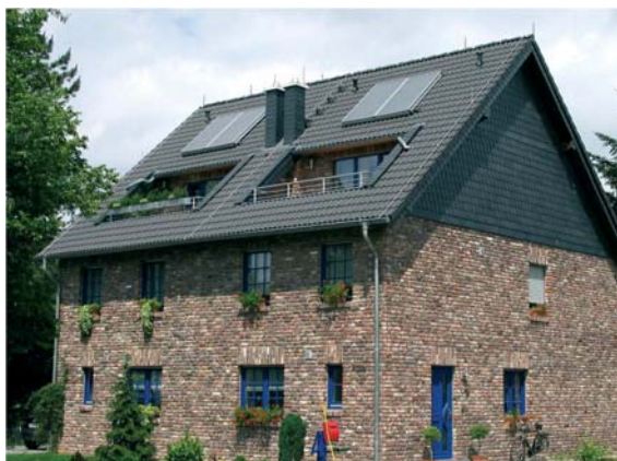
Figura 5.1.2.4 Edificio con impianto fotovoltaico Fonte: Blitzschutz Wettingfeld, Krefeld, Germania
