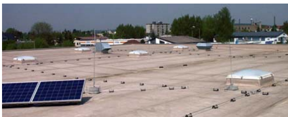
Figura 5.1.3.3 Applicazione di aste di captazione
