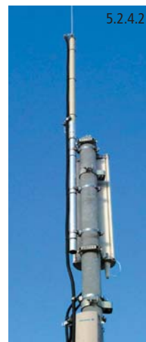
Figura 5.2.4.1 Dispositivo di captazione isolato con distanziatori
