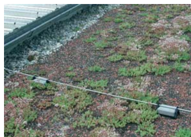
Figura 5.1.7.3 Posa del conduttore sopra il manto di copertura
