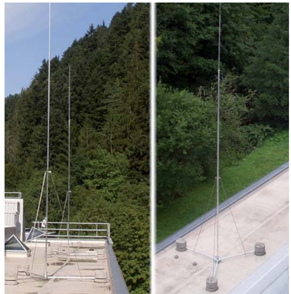
Figura 5.1.11.1 Protezione dalle scariche dirette con aste indipendenti
