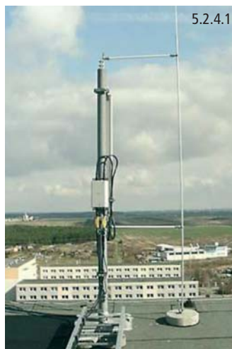
Figura 5.2.4.1 Dispositivo di captazione isolato con distanziatori
