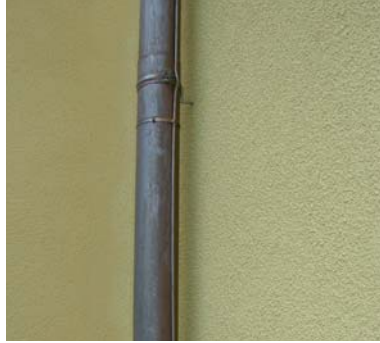
Figura 5.2.2.2.4 Calata lungo il pluviale
