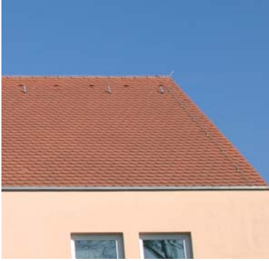
Figura 5.1.2.1 Dispositivo di captazione su tetto a doppio spiovente
