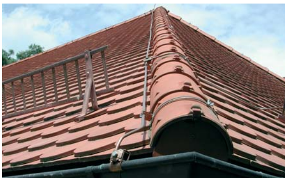
Figura 5.1.1.18 Tetto a falda con staffa portafilo
