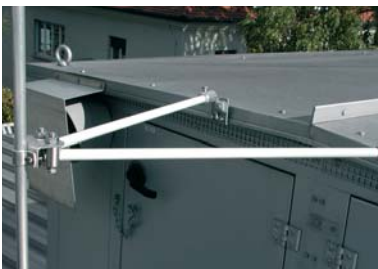
Figura 5.1.8.4 Sostegno angolare dell'asta di captazione
