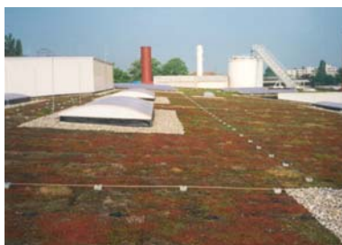
Figura 5.1.7.2 Impianto di captazione su tetto verde
