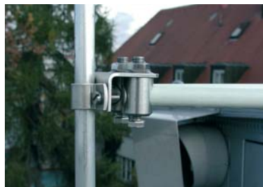
Figura 5.1.8.5 Fissaggio dell'asta di captazione
