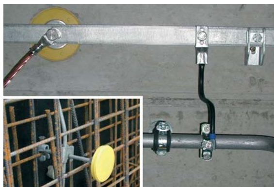
Figura 5.5.2.8 Punto fisso di messa a terra
