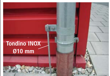
Figura 5.2.2.1.4 Messa a terra pluviale
